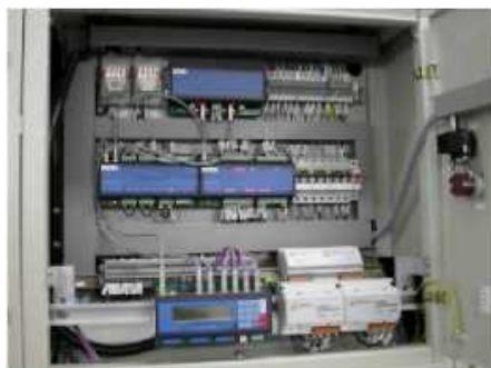
CZAT в распределительном устройстве (фидерная ячейка)
